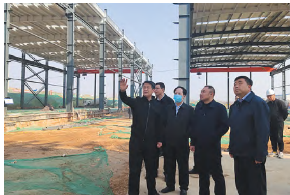
厂房建设情况检查
