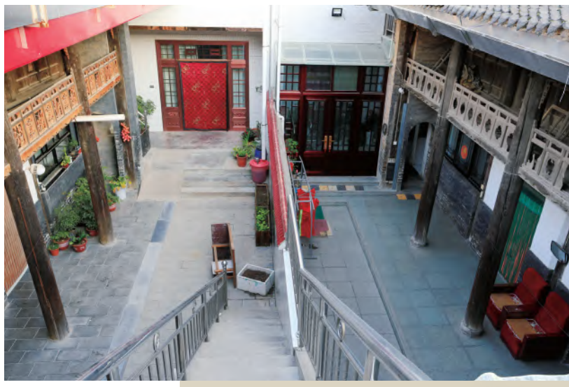
◎ 城关北街两层古木楼
