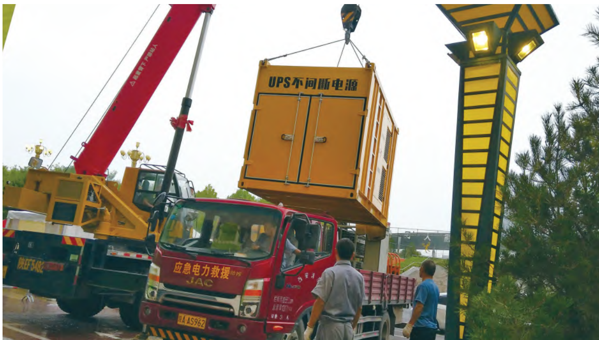
◎ 全国十四运会摔跤赛场馆安装电力情景
