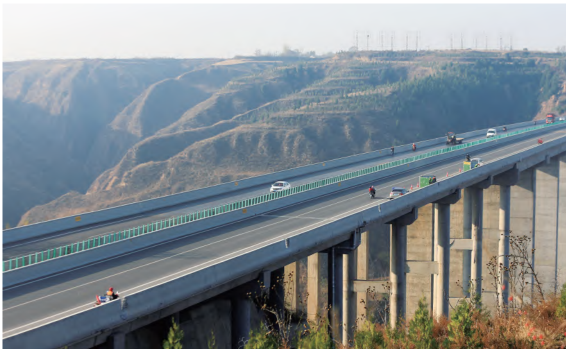
◎ 加宽变为单行道后的金水沟大桥
