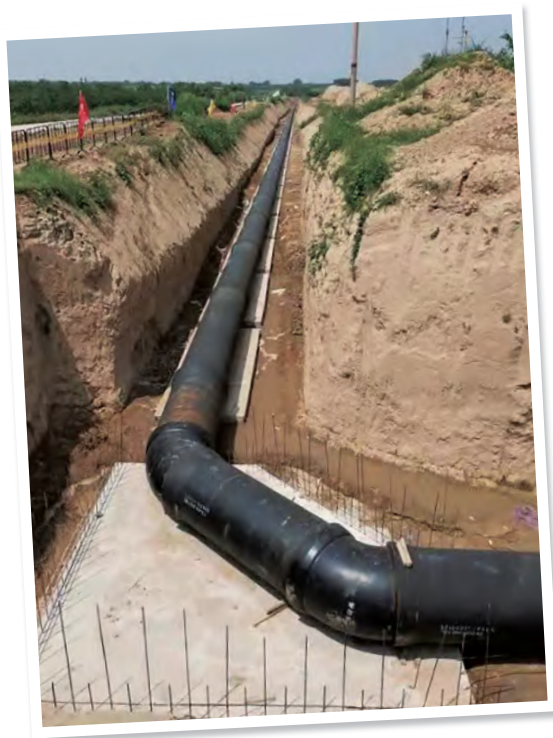
◎ 管道安装铺设
