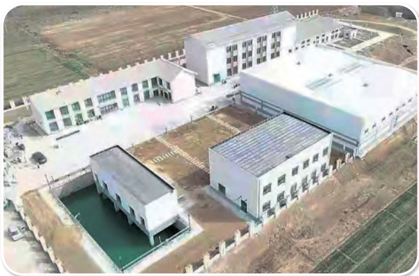
◎ 渭北高效节水灌溉工程合阳大伏六一级站
