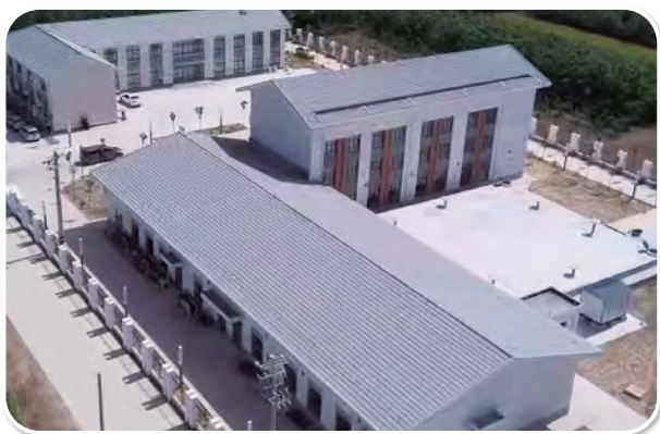
◎ 渭北高效节水灌溉工程合阳临皋二级站
