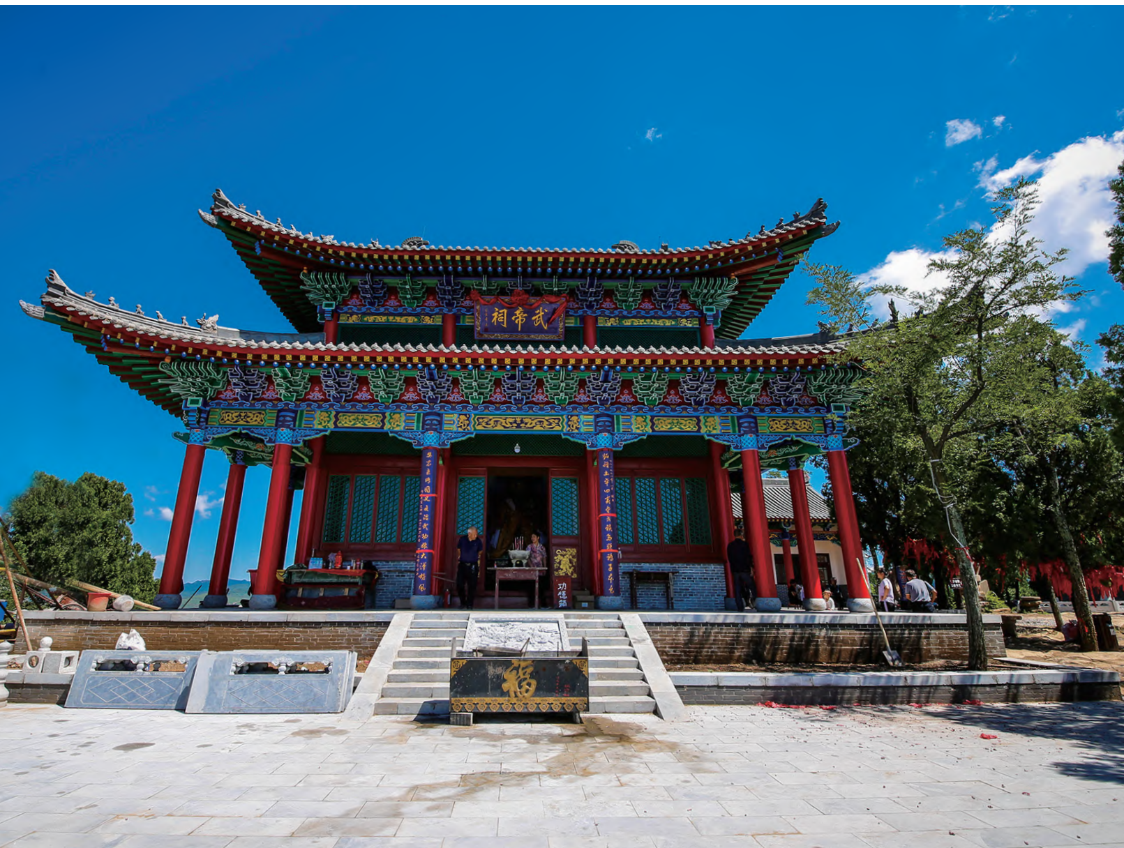
◎ 武帝山建筑群在建项目
