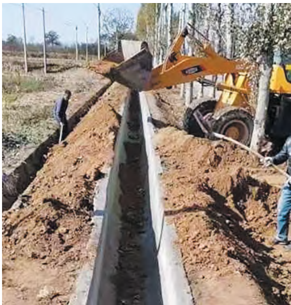
新民所支渠整修
