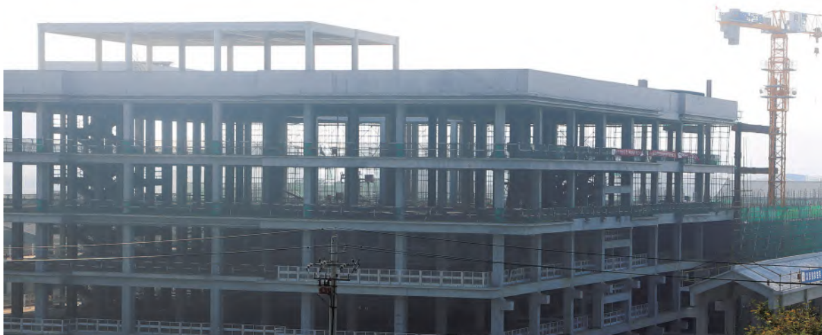
◎ 合阳县政府中心广场在建项目
