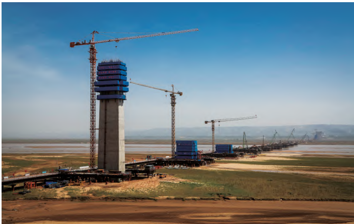
◎ 荷凤高速黄河特大桥合阳岔峪段在建项目
