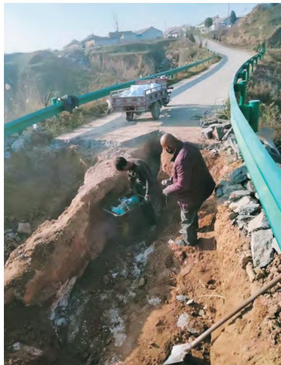
高北十支倒虹修复现场
