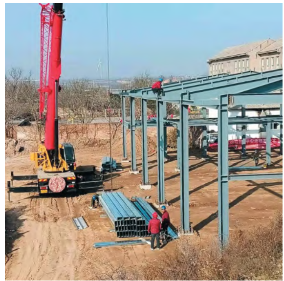
坡赵社区礼堂加紧施工现场
