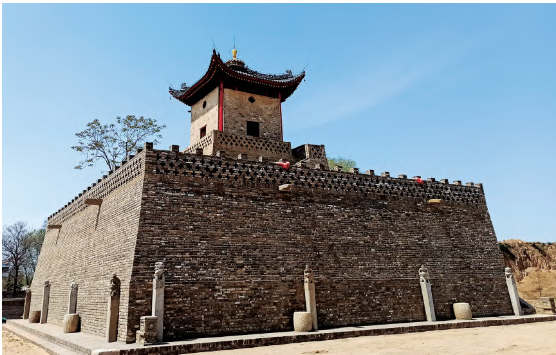
◎ 重修后的黑池救郎庙角楼
